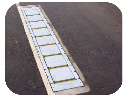
▲ 一體成形的嵌入式混凝土基坑
