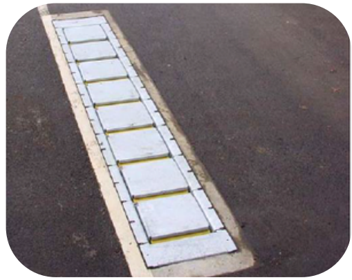
▲ 一體成形的嵌入式混凝土基坑
