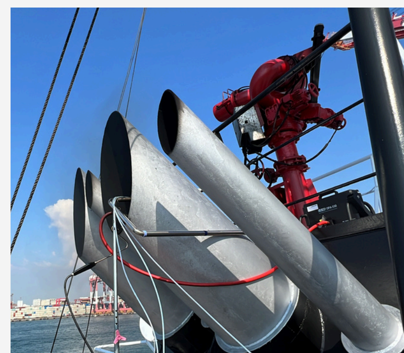
⤴ 連接船舶排煙口實測
