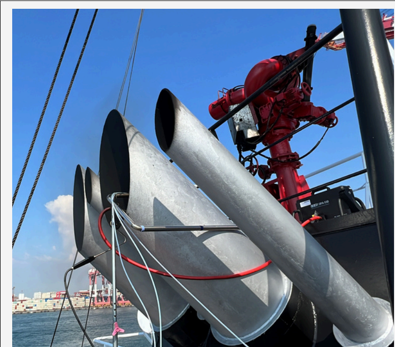
⌘ 連接船舶排煙口實測
